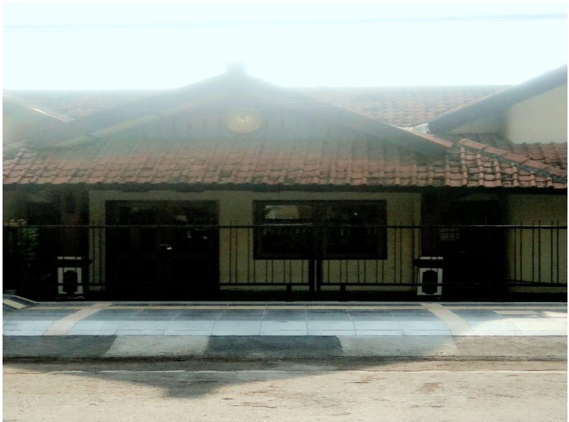
Gedung Lama Pengadilan Agama Kendal Kelas 1-A
